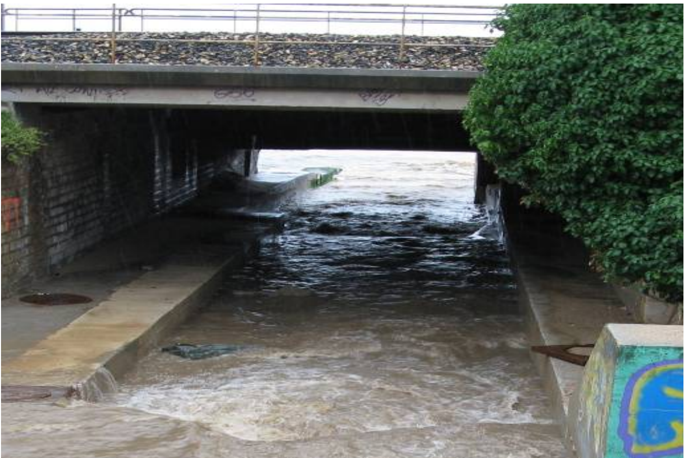
Exutoire bien dégagé avant les travaux de juin 2015
